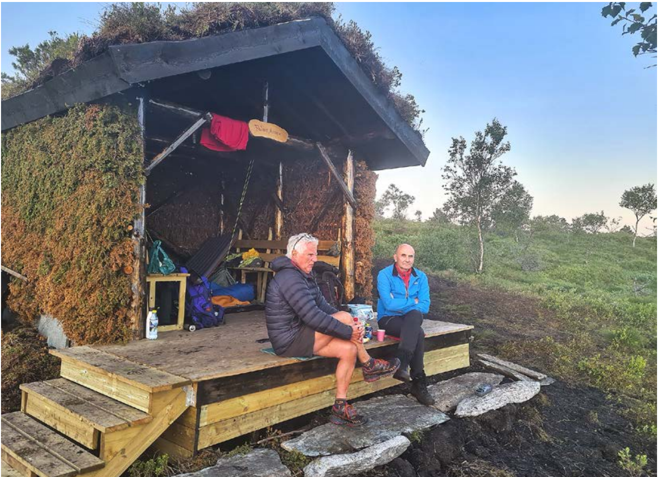
Grindbygget «Peterslassen» er bygget på dugnad på Solbakkefjellet.
